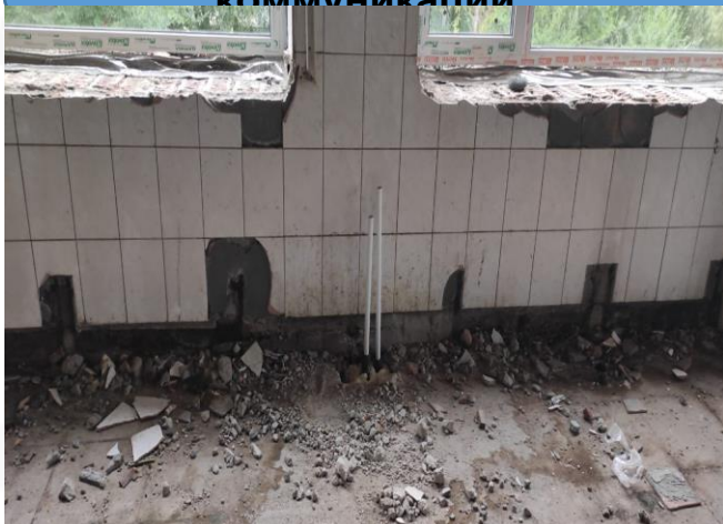
Ремонт инженерных коммуникаций
