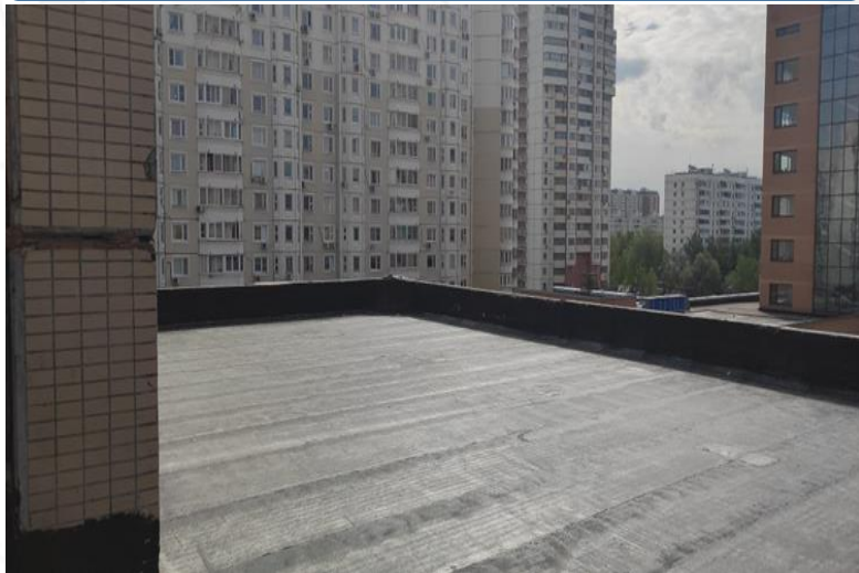
Кровля здания Силикаты
