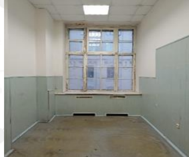
Помещение № 398 до ремонта
