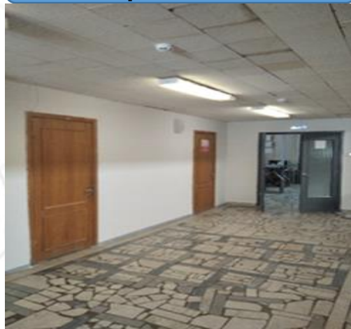
Холл КСК после ремонта
