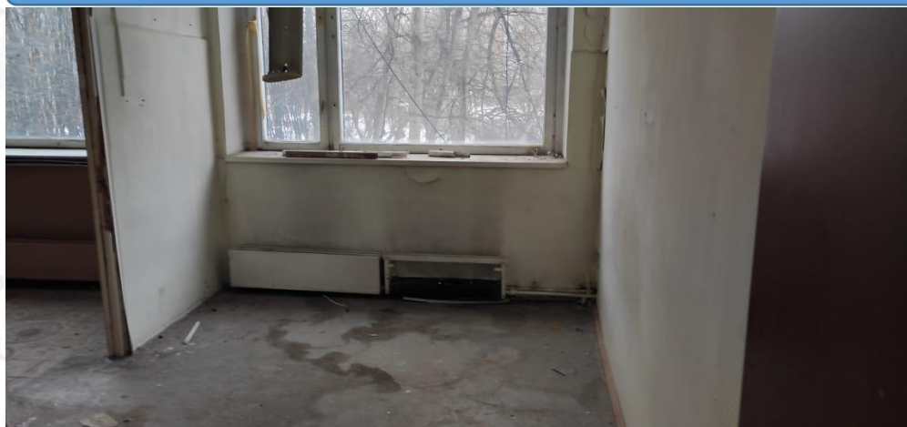
Ремонт инженерных коммуникаций
