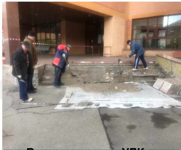
Входная группа УЛК до ремонта
