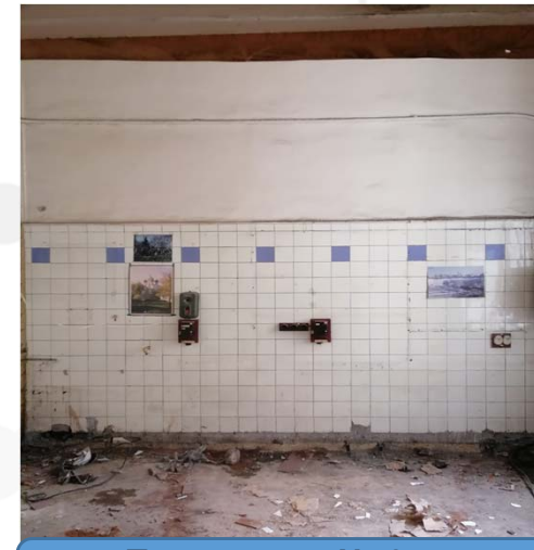
Помещение № 277 до ремонта
