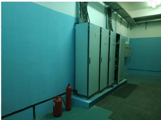
Щитовые после ремонта
