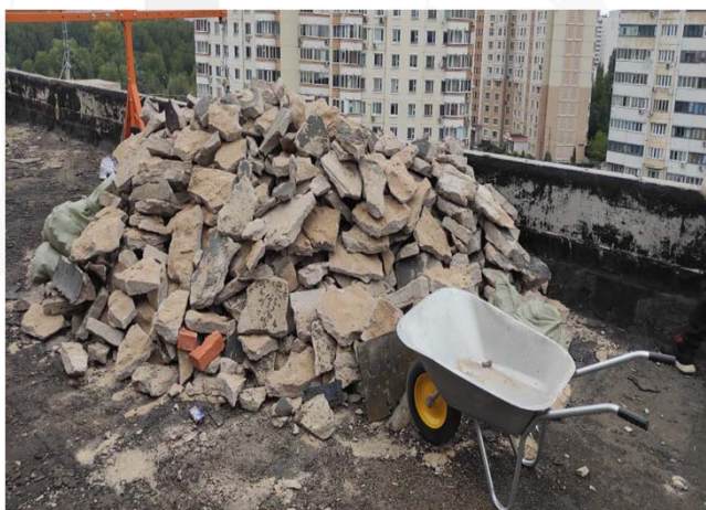
Ремонт кровли корпуса ИХТ
