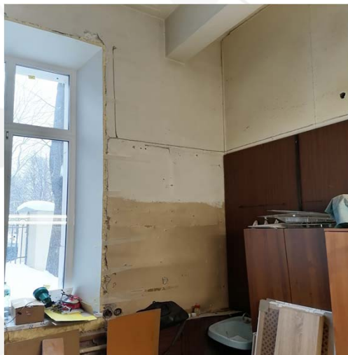
Помещение № 147 до ремонта
