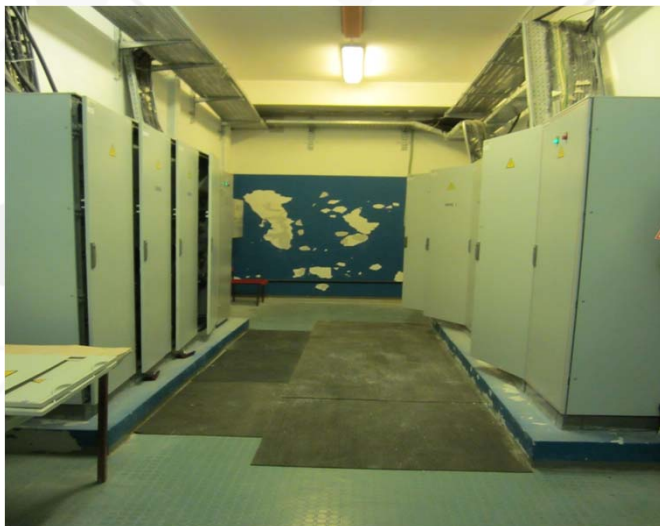
Щитовые до ремонта
