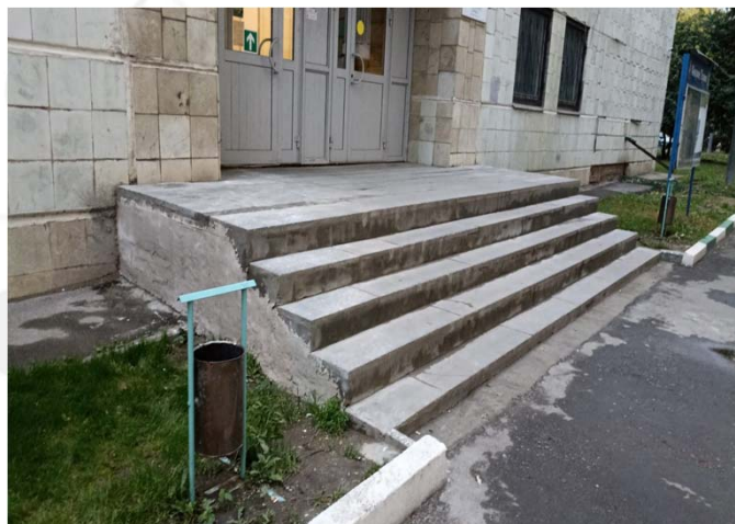
Отремонтированная вх. Группа КСК
