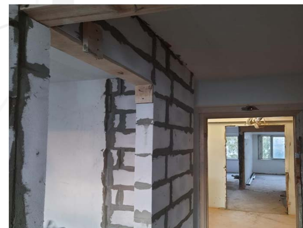
Ремонт помещения в СГ д.23к1
