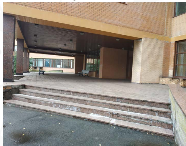
Входная группа УЛК после ремонта
