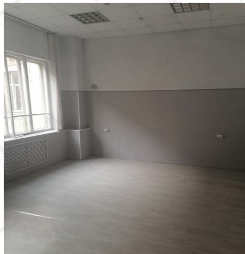
Помещение № 395 после ремонта
