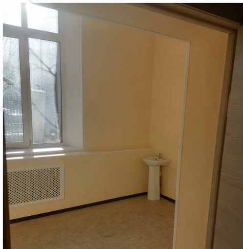
Помещение № 147 после ремонта
