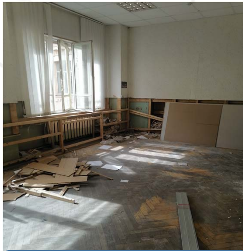
Помещение № 395 до ремонта
