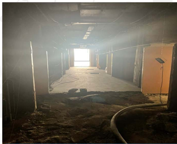
Ремонт 3-го этажа корпуса ИХТ
