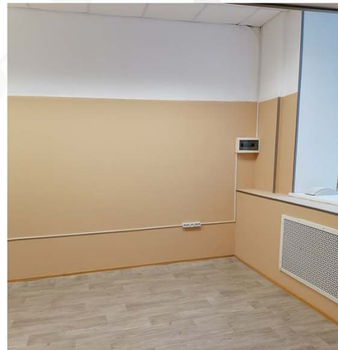
Помещение № 277 после ремонта
