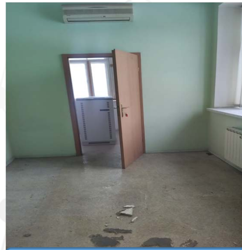
Помещение № 305 (корп. 5) до ремонта
