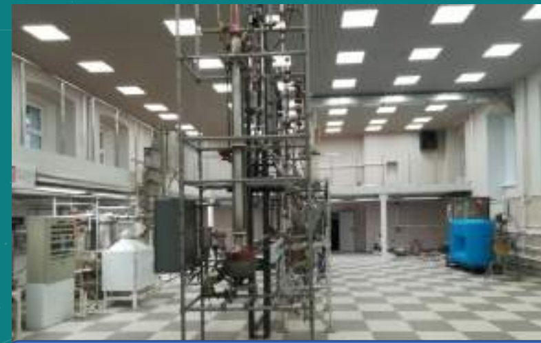
Ремонт Ремонт Лаб. № 77 МК Фото после
