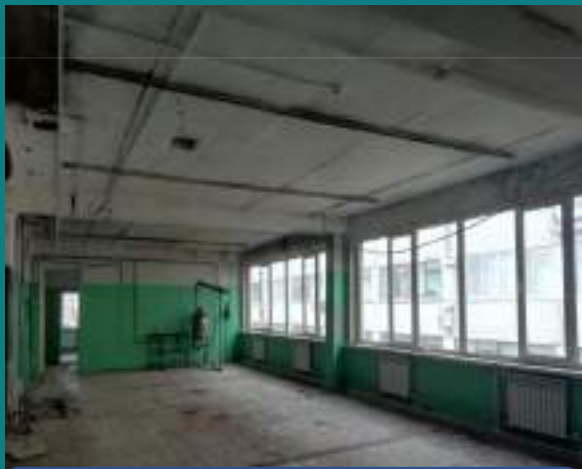
Ремонт кафедры «ПАХТ» Фото до
