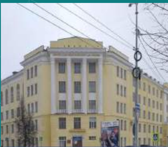
Ремонт фасада Фото после
