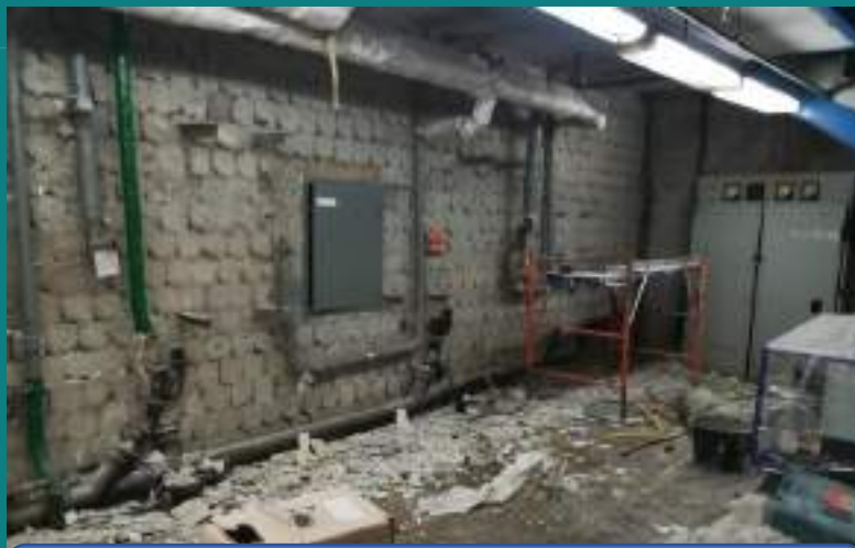
Ремонт Лаб. № 77 МК Фото до
