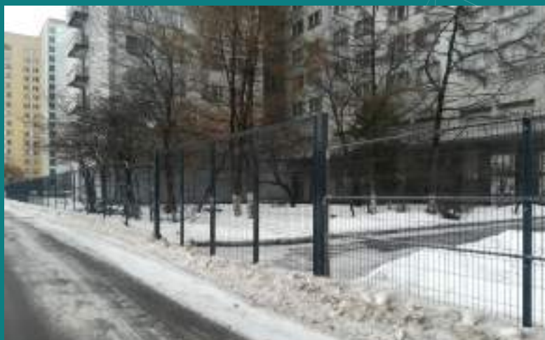
Устройство периметрального 3D ограждения СГ
