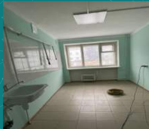
Ремонт МОП общежитие №1 Фото после
