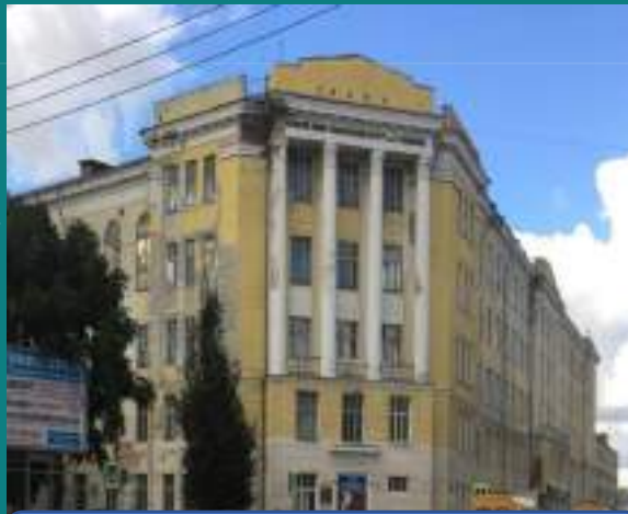
Ремонт фасада Фото до
