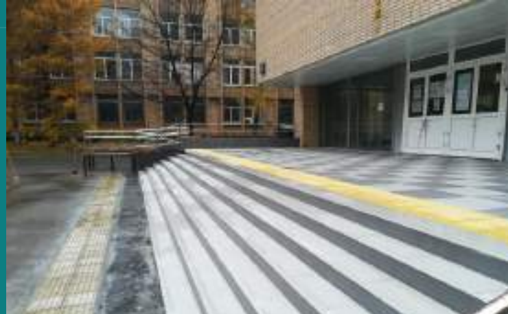
Ремонт входной группы ИХТ ТК Фото после
