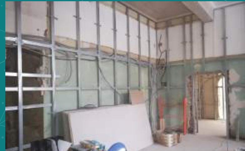
Проведение ремонт. раб. (Ректорат)
