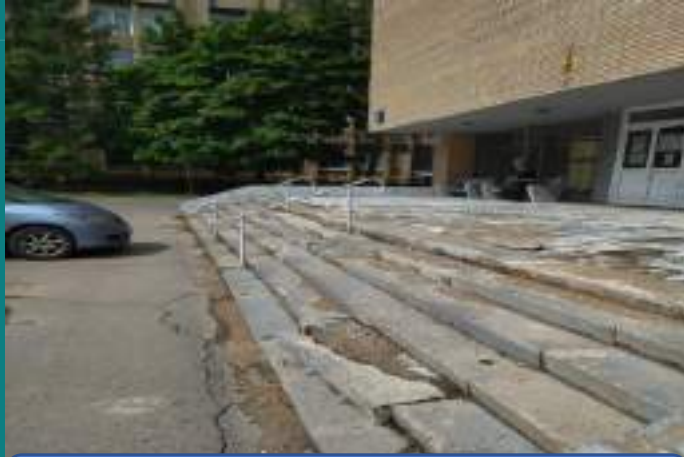
Ремонт входной группы ИХТ ТК Фото до
