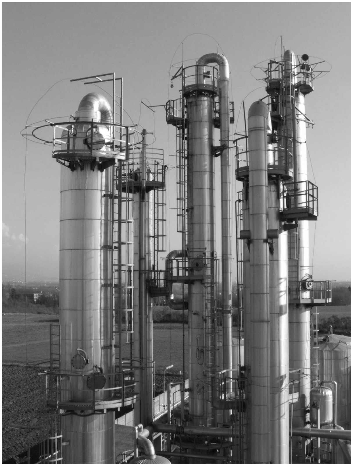
Рис. 37. Промышленные ректификационные колонны
